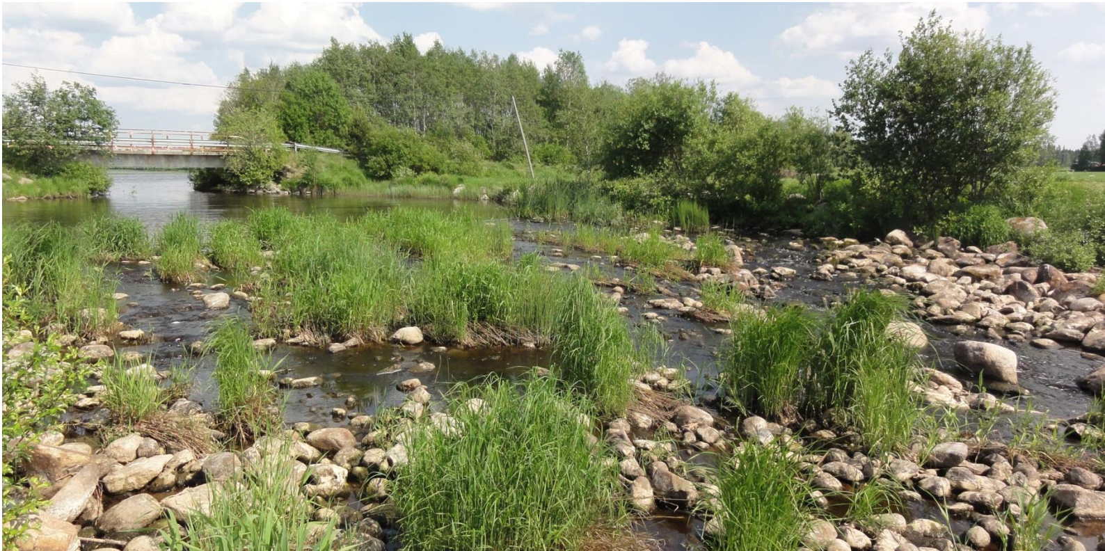
Kuva 3. Erkkisjärven alapuolista pohjapatorakennelmaa
