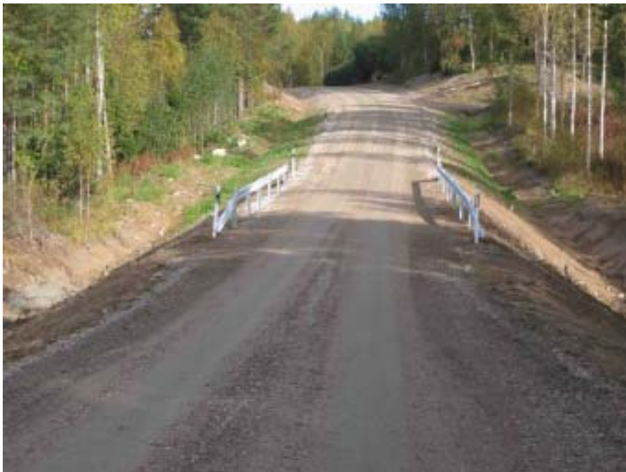
Kuva 12. Kaiteet ja reunapaalut lisäävät turvallisuutta.
