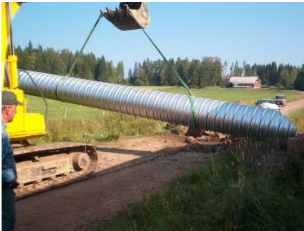
Kuva 11. Rummun uusiminen.
